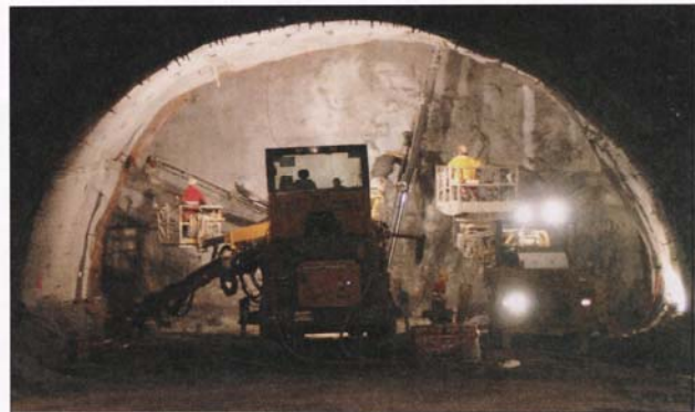
Bild 8. Befestigung eines Tunnelabschnittes mit Spritzbeton
