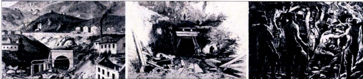
Bild 2. Bilder vom Bau des alten Gotthard-Tunnels
