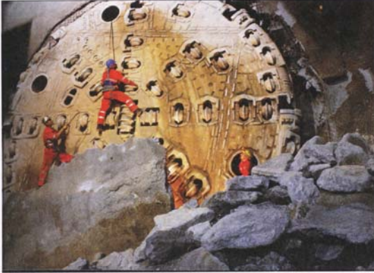
Bild 5. Steinbohrmaschinen, Gripper genannt, sind tonnen-schwere technisch hoch entwickelte Maschinen, die es je nach Röhrendurchmesser mit bis zu 15 m großen Fräs-köpfen gibt (Bild: Herrenknecht, Schwanau)
